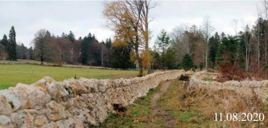
On peut ici observer la reconstruction d'un mur en pierres sèches aux Posats, près de la Montagne de Cernier, réalisée dans le cadre d'un projet de revalorisation paysagère autour du chemin des Pionniers. Plus de 1,2 km de murs ont été restaurés entre 2016 et 2021 dans quatre secteurs d'intervention.
