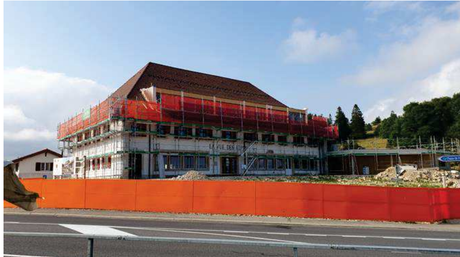
Figure 5 : Travaux de rénovation de l'hôtel-restaurant de La Vue-des-Alpes, été 2025.
