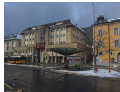
Figure 29 : Cernier, Place arrêt de bus – espace exclusivement routier, Photo EA
