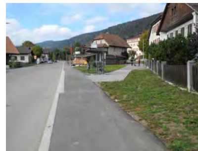
Figure 32 : Petit Chézard – Trottoir continu, Photo EA
