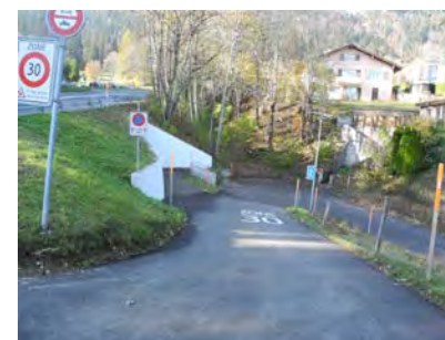
Figure 54 : Hauts-Geneveys, passage sous-voie à l'entrée nord-ouest, route cantonale limitée à 70 km/h, Photo
