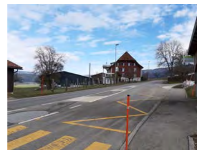
Figure 44 : Saules, Arrêt de bus sur la route cantonale, Photo EA
