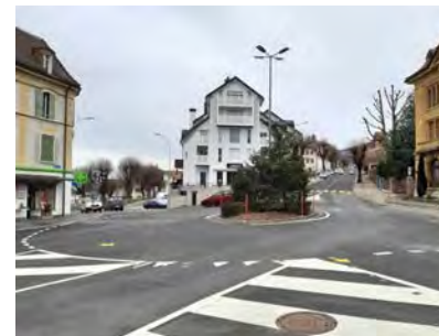
Figure 28 : Cernier, Rond-point entrée ouest – espace exclusivement routier, Photo EA
