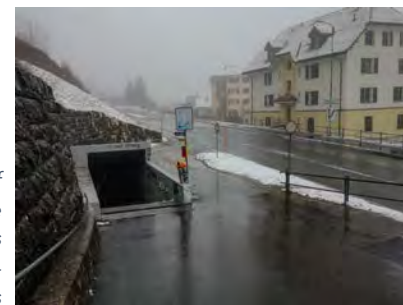
Figure 12 : Dispositif de traversée sécurisée pour les piétons aux Hauts-Geneveys
