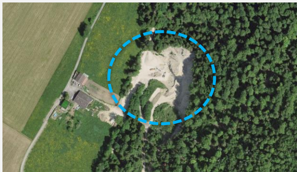
Carrière Sous-le-Mont, Villiers
