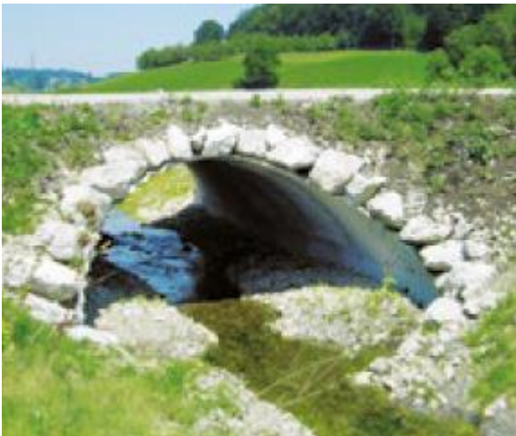
Figure 4 : exemple de buse en acier ondulé
