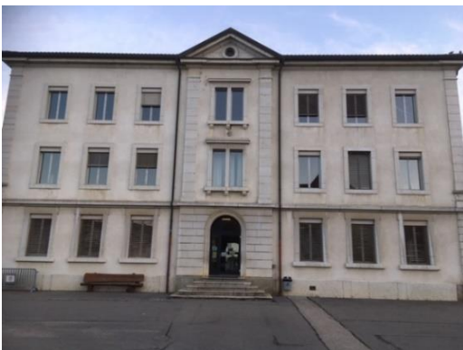
Vue de la façade "sud"
