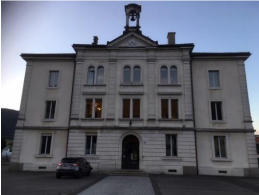
Vue de la façade "nord"
