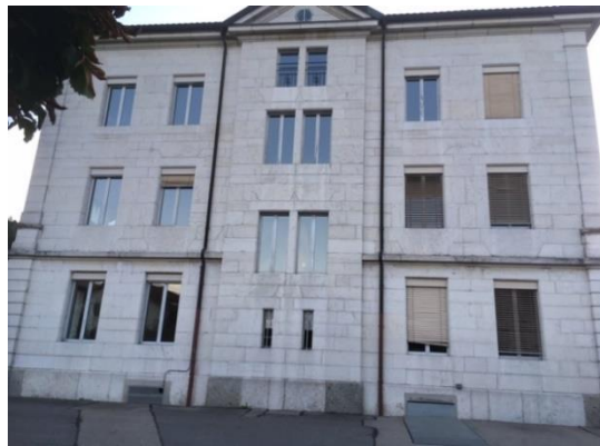
Vue de la façade "ouest"
