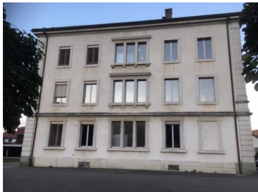
Vue de la façade "est"
