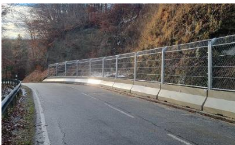
Figure 6 : exemple d'une clôture routière
