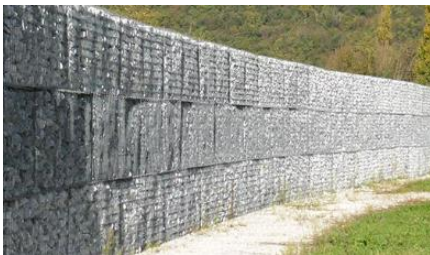
Figure 5 : exemple de gabions
