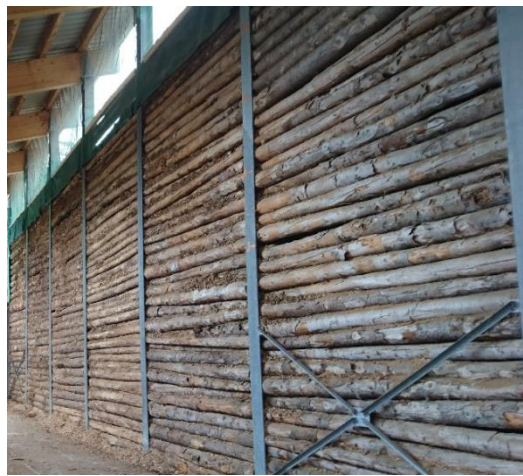
Figure 5 : Parois du stockage à plaquettes de La Sagne
