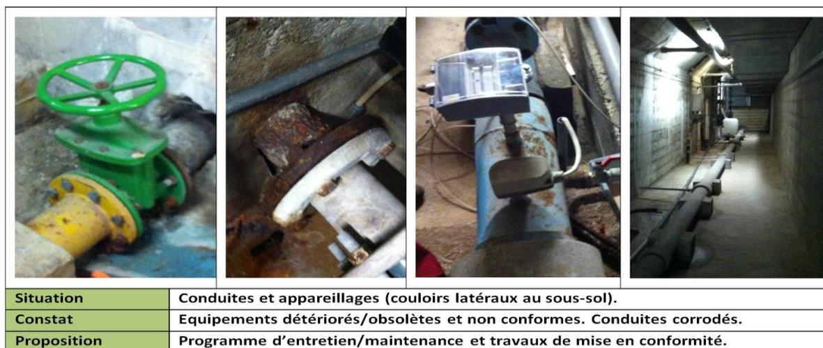
Figure n°4 : Couloir latéraux (sous-sol piscine) – Conduites et appareillages
