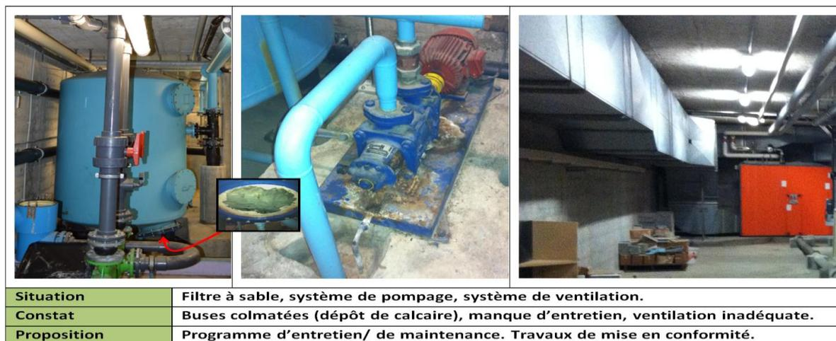
Figure n°5 : Couloir latéraux (sous-sol piscine) – Traitement, équipement électromécanique et ventilation
