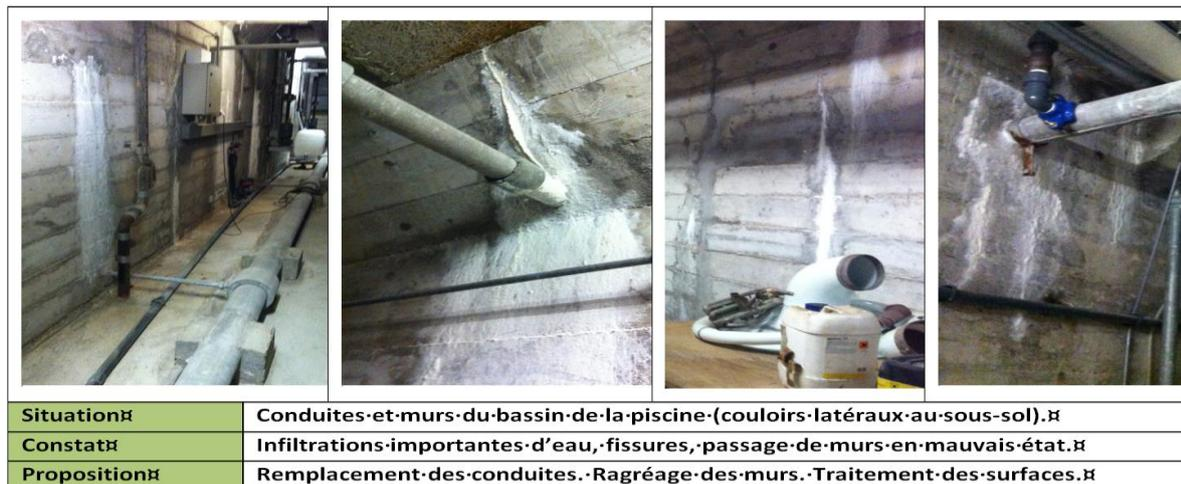
Figure n°3 : Couloir latéraux (sous-sol piscine) – Fissures et infiltration
