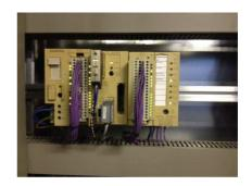
Dans la solution proposée, toutes les cartes d'entrées sorties des automates sont remplacées par des cartes de nouvelles générations. Ces cartes restent compatibles avec les modules d'entrées sorties de type ABE7 installés. Par conséquent, aucune modification du câblage électrique n'est nécessaire.
