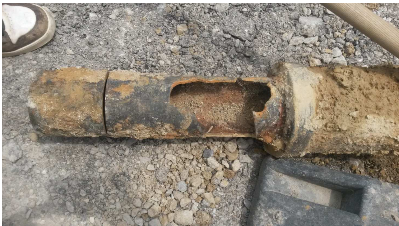
Figure 1 : Etat de la conduite lors de la fuite du 17 juin 2014
