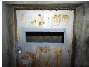
Figure 9 : exemple de porte d'accès tel qu'envisagé au bunker, avec l'ouverture pour le passage des chiroptères
