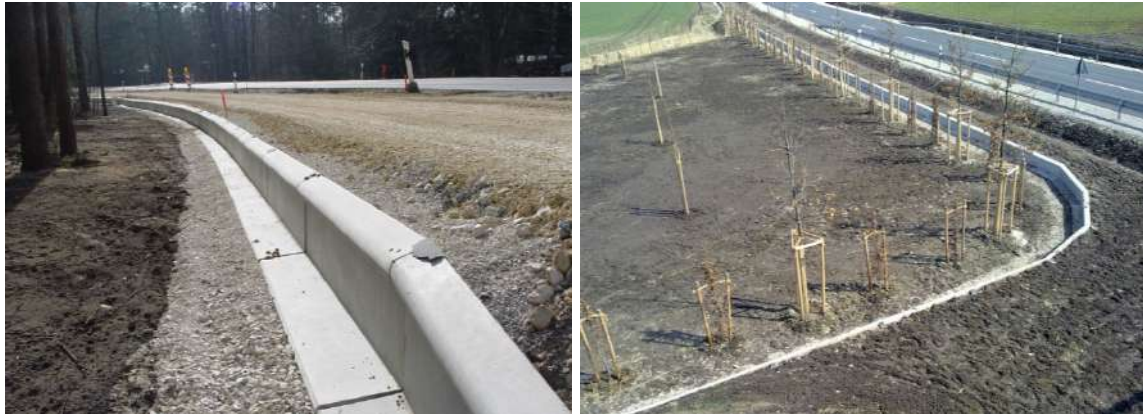
Figure 4 : Exemples de barrière fixe à amphibiens permettant son franchissement dans une seule direction (photo : ©Maibach)
