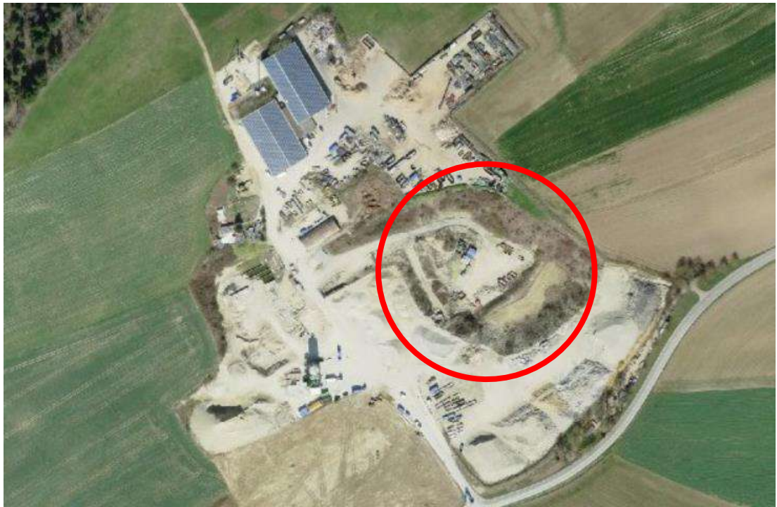
Figure 15 : Site de rive, photo aérienne 2017 – carrière à combler (source : SITN)
