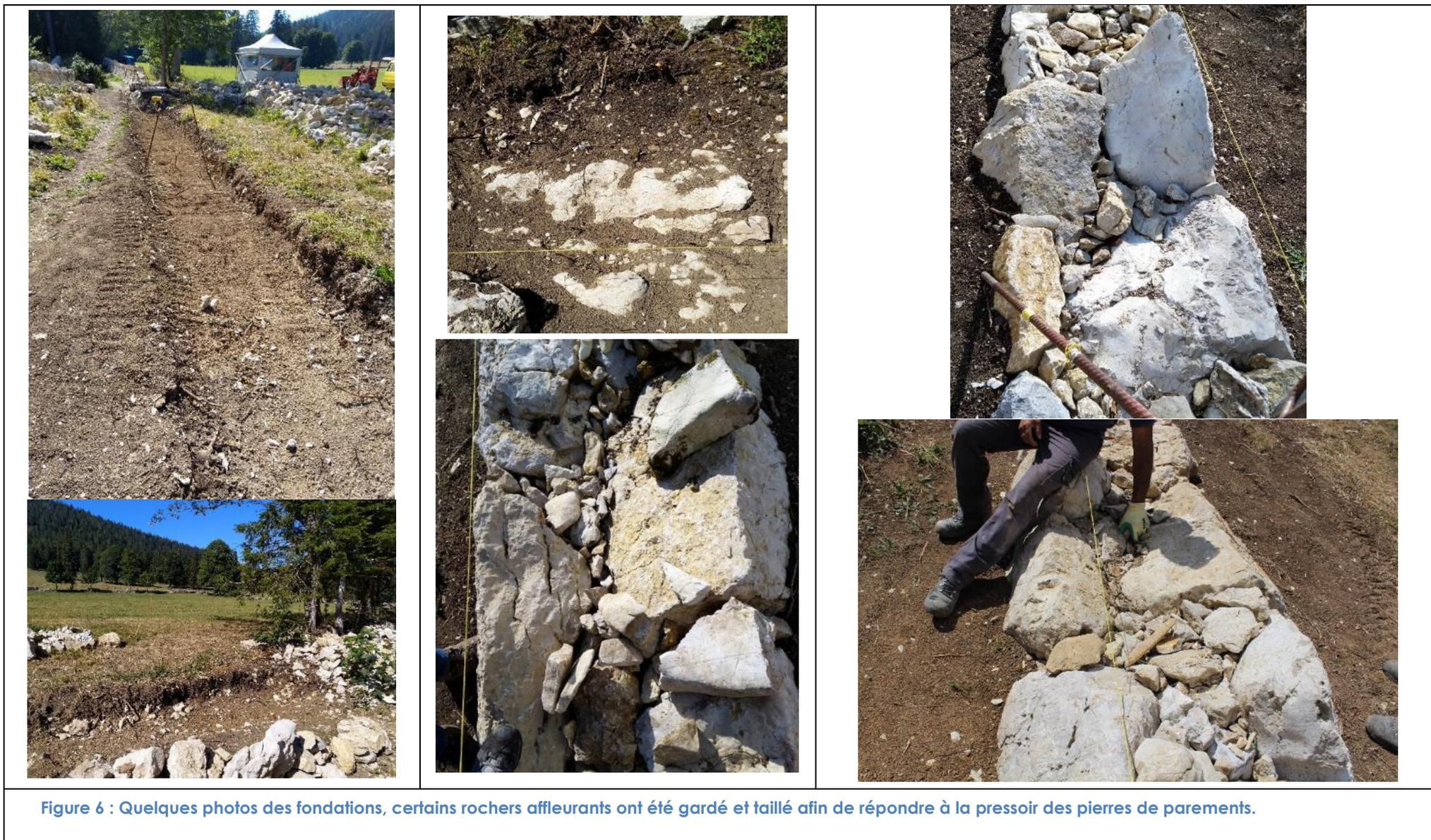
Figure 6 : Quelques photos des fondations, certains rochers affleurants ont été gardé et taillé afin de répondre à la pression des pierres de parements.
