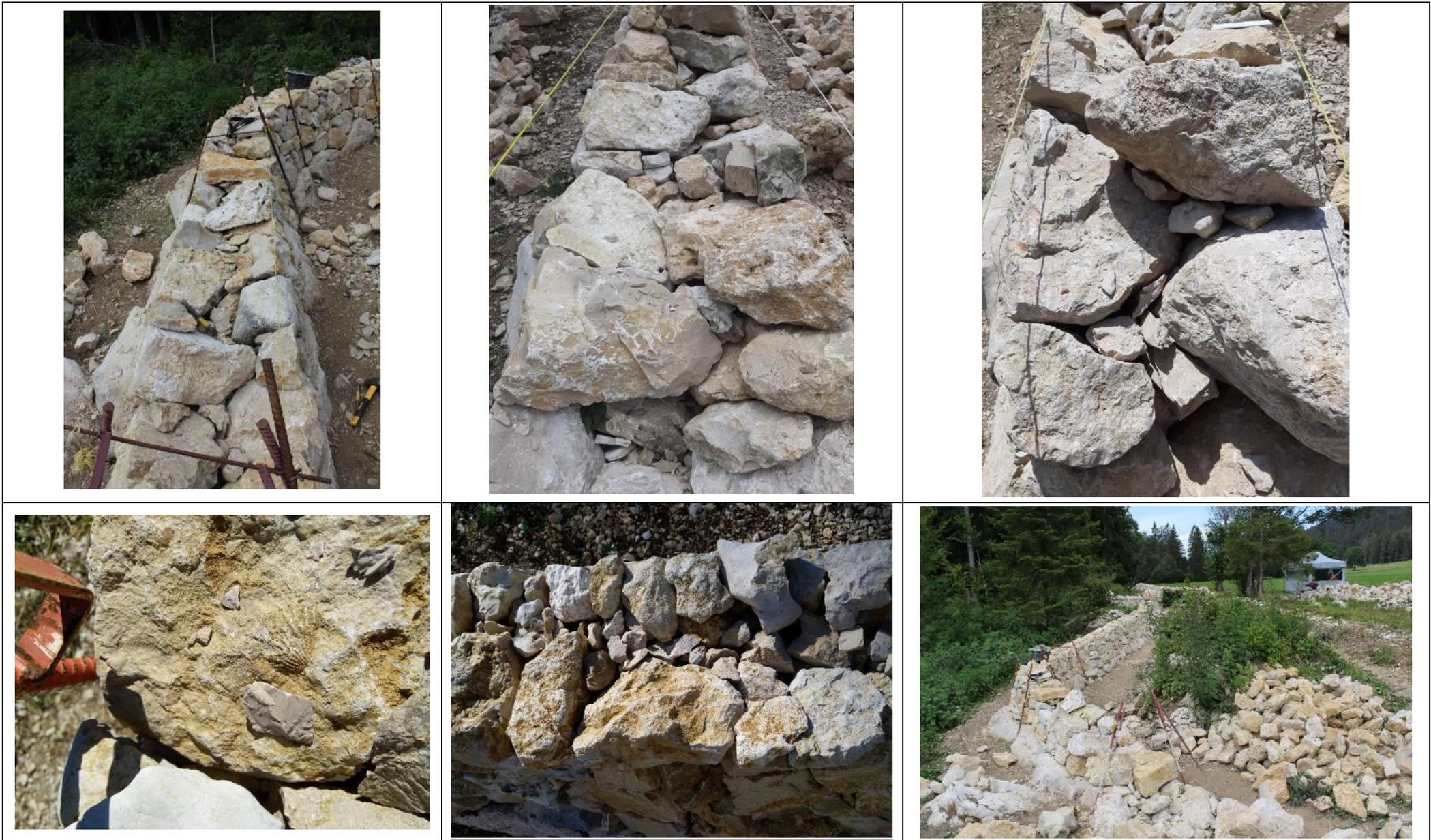
Figure 7 : Structure des parements avec l'intégration de boutisses entrecroisées
