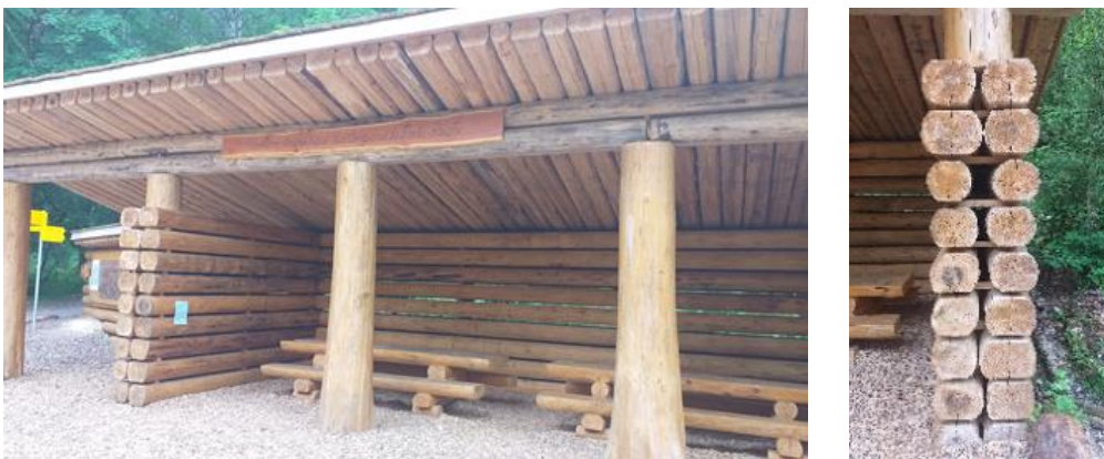
Figure 3 Exemple de pavillon touristique avec parois doublées à Môtiers
