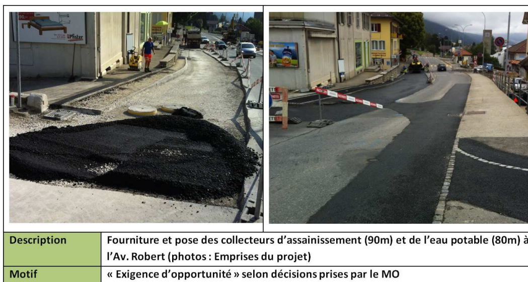
Figure 8 : Extension des réseaux assainissement/eau potable (Avenue Robert - env. 90-100m)
