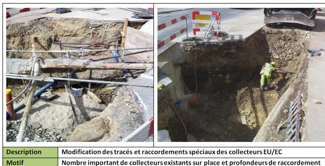
Figure 7 : Travaux spéciaux pour le raccordement des collecteurs EU/EC.
