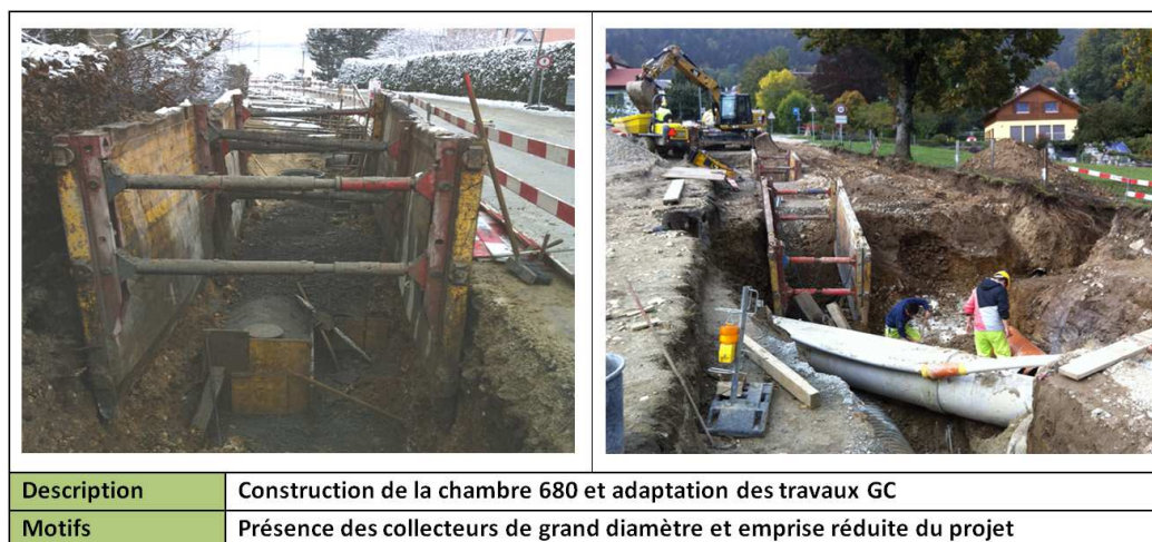
Figure 2 : Construction de la chambre EC 680 et adaptation des travaux
