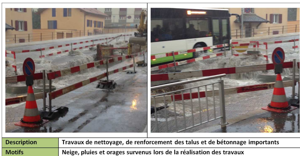
Figure 3 : Travaux de nettoyage, de renforcement des talus et de bétonnage importants
