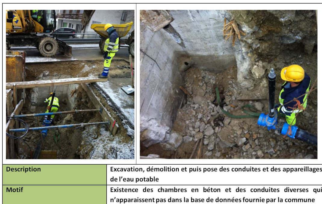
Figure 6 : Excavation, démolition importantes et pose des conduites d'eau potable
