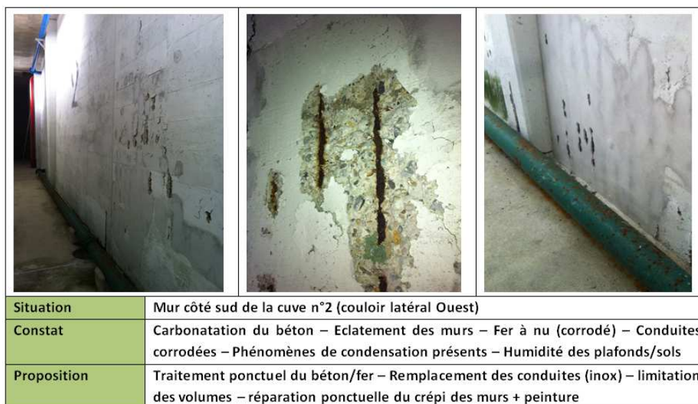
Figure n°3 : Mur côté sud de la cuve n°2 (couloir latéral Ouest)
