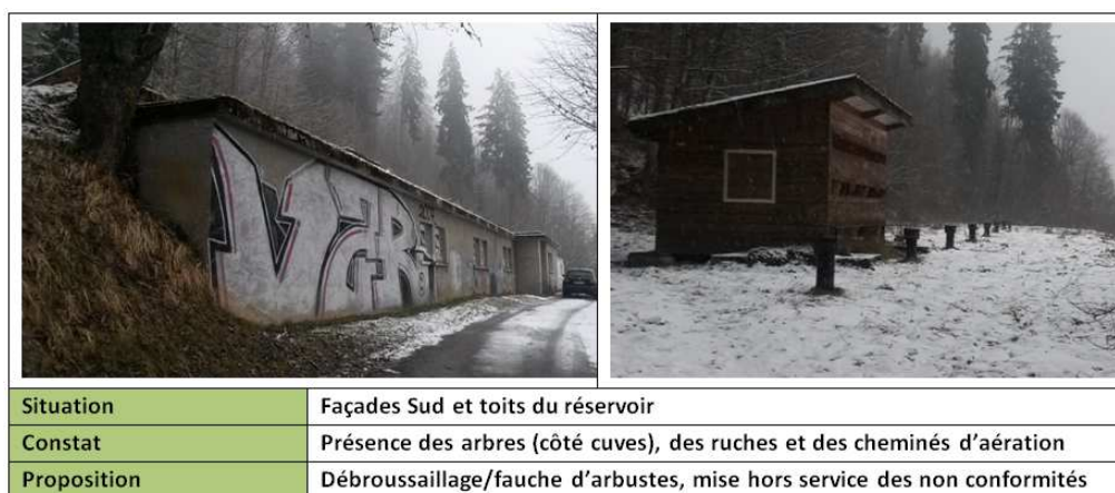
Figure n°1 : Façades Sud et toits du réservoir
