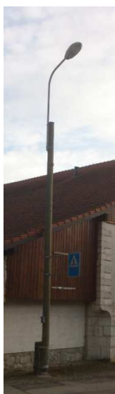
Mâts de l'éclairage public encore en bois
