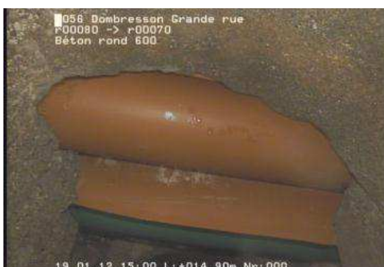
Photo 3 : raccordement privé traversant l'ancien collecteur
