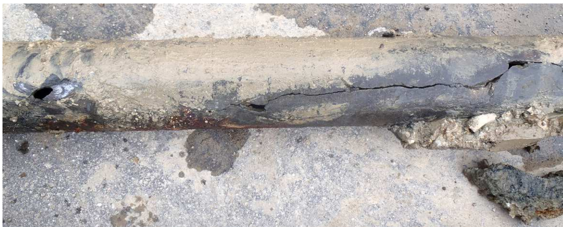
Photo 6 : état de la conduite d'eau potable (photo prise lors d'une réparation de fuite)
